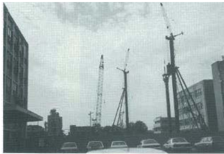
研究棟の建設(昭和61年)
